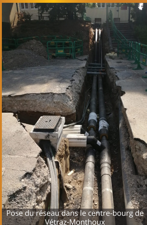
Pose des canalisations en cours, en direction du local chaufferie
